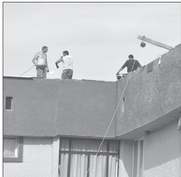
Усилено се работи по покрива на детска градина „Звънче“
